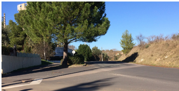
Un talus important à traiter à l'Est
