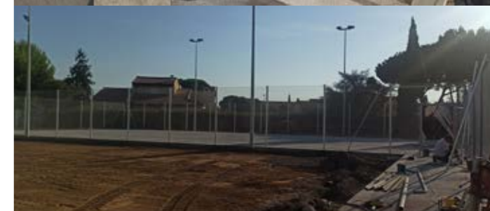
Travaux du tennis
