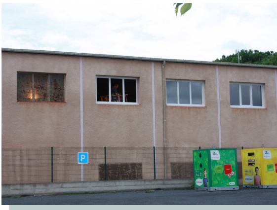
Travaux gymnase : avant / pendant / après
