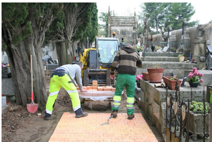
Pose de pavés autobloquants dans l'allée du cimetière
