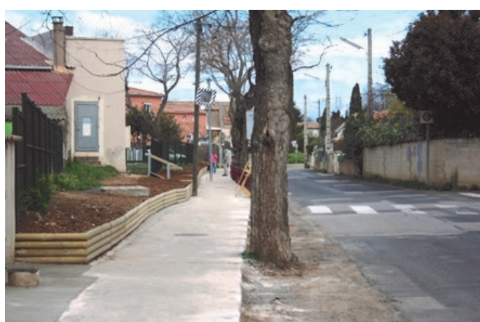
Pose des rondins de bois
