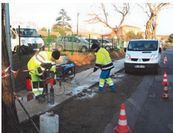
Trous pour les barrières
