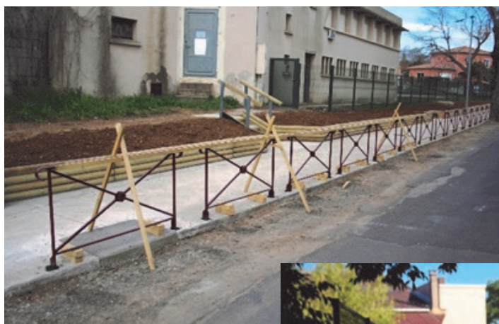
Pose des barrières
