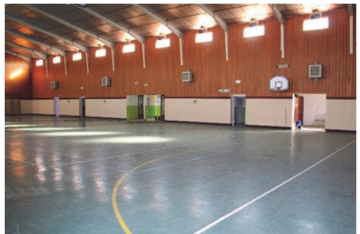
Le bardage en bois est posé !
