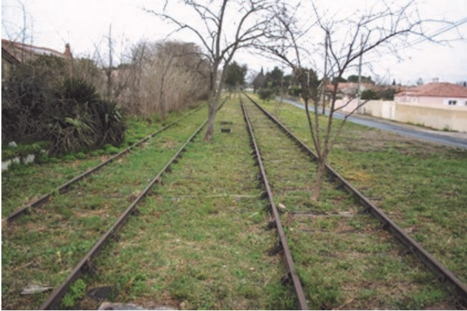
Ancienne voie ferrée avant travaux
