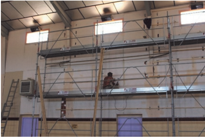
Gymnase avant travaux
