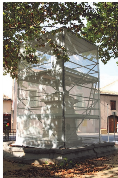
Mise en place des échafaudages
